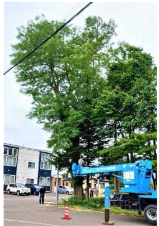
高所作業車を用いて安全に。
